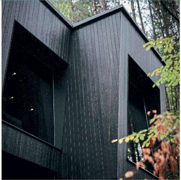
Konservierte Oberfläche: Die Lodge des Hotels Fischerwirt in Faistenau wartet mit einer besonders robusten Fassade aus vorverbranntem „Kebony“-Holz auf.
