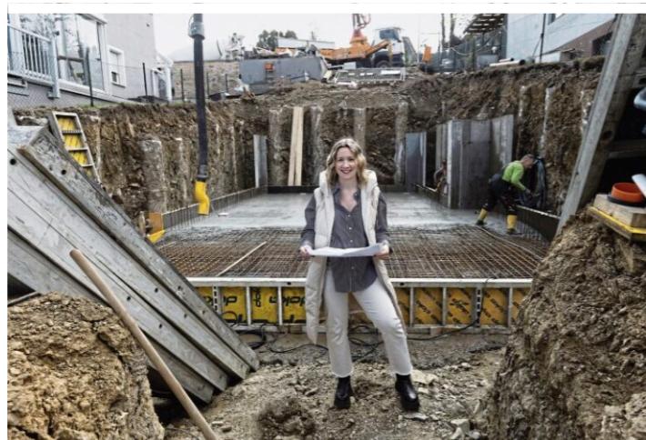
Das Grundstück, eine einzige Baugrube: die Bauherrin mit den Plänen
