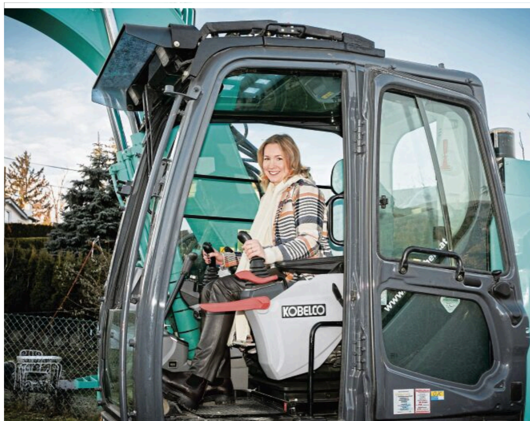
Die Bauherrin packt mit an: Hier im Bagger auf der Baustelle im Jänner dieses Jahres
